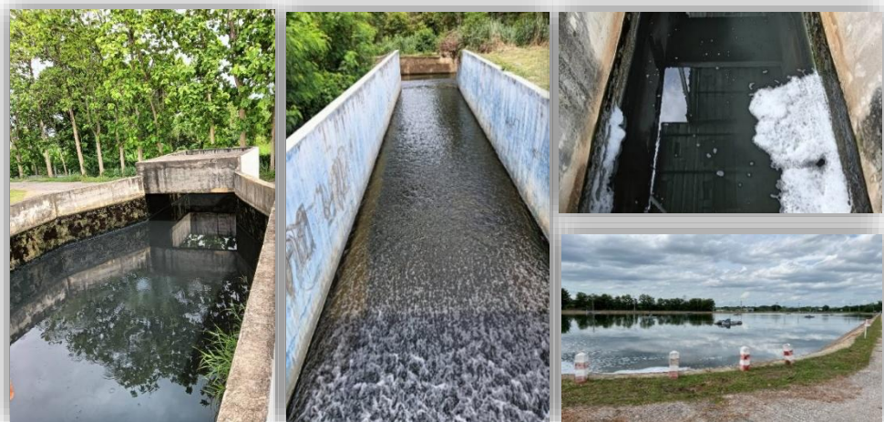
รูปภาพที่ 15 โรงบำบัดคุณภาพน้ำ เทศบาลนครเชียงใหม่
